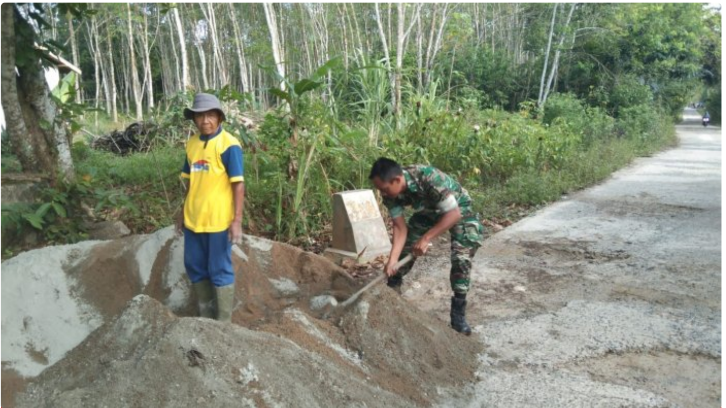
Babinsa Bantu Gotong Royong Pengecoran Jalan
